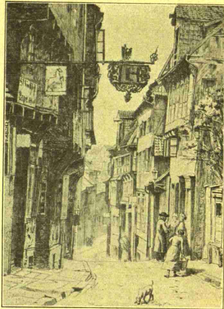
Abb. 128. Blick in die Schuhstraße.
